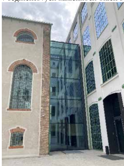
Obr. č. 5: Detail novotvaru preskleného krížu spájajúceho budovu strojožne a pradiarne
