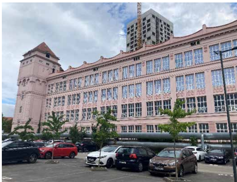
Obr. č. 6: Továrň Danubius v pozadí s výškovou budovou s názvom Danubius One Autor: Nela Szabóová
